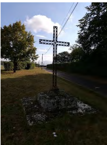
Figure 19 - Croix de carrefour à Bouglainval
