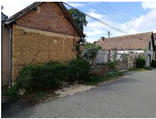
Figure 29 - pignon en bauge rue des Eternys
